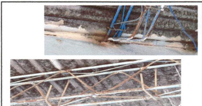
Foto1: Sustitucion de soporte de techo de metal por oxidacion
