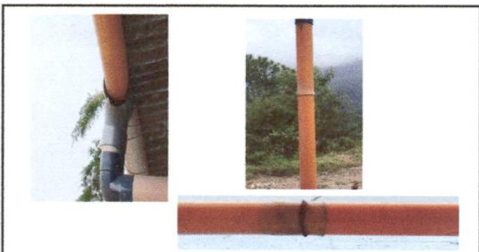
Foto 5: Sustitucion de canal y baja de agua tubo pvc
