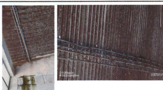
Foto 2: Sustitucion de lamina por oxidación y filtración de agua en tiempo de lluvia
